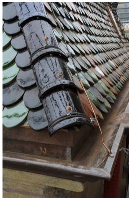
D'une façon générale, l'état de conservation des couvertures était satisfaisant. Les tuiles vernissées qui dataient de la restauration de 1867-70 et qui avaient remplacé les tuiles canal et plates précédentes étaient encore fonctionnelles et en bon état.
