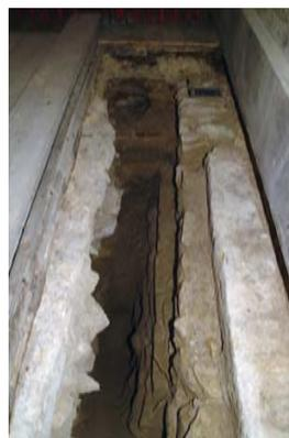
**Illustration du haut:** vue des fouilles effectuées lors de l'installation de l'orgue St Martin en 1995. On peut voir les fondations des piliers des 12<sup>e</sup> et 13<sup>e</sup> siècles et le réseau de caniveaux souterrains pour le chauffage (photographie OPAN, 1995).
