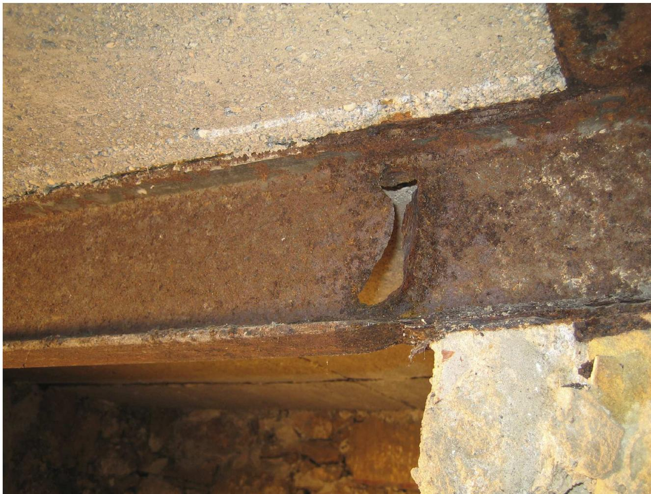
Réalisé entre 1867 et 1870 par Léo Châtelain, le sol de la nef et des bas-côtés est partiellement composé d'une structure mixte, faite de petites dalles en béton armé (un modernisme dans les années 1860) portées par des solives métalliques.
