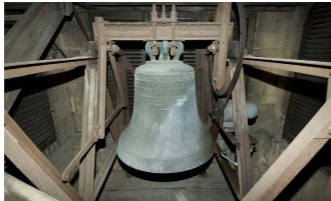
Les tours de l'avant-chœur abritent deux beffrois et quatre cloches: un beffroi médiéval de charpente à trois cloches (1503, 1786 et 1823) dans la tour sud, un beffroi métallique portant une seule cloche (Ruetschi, 1930) dans la tour nord.
