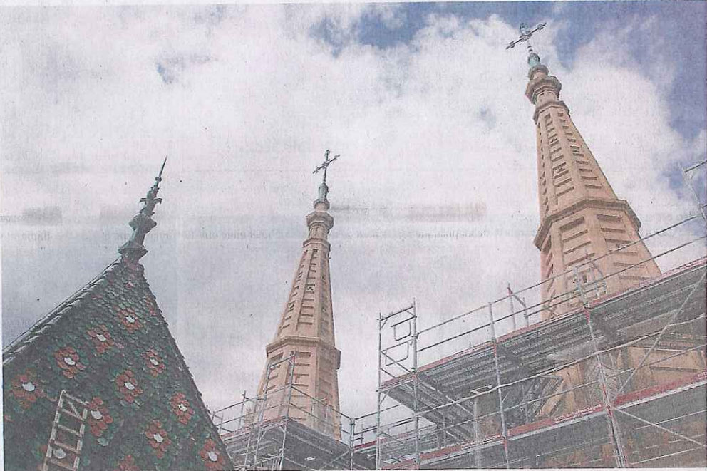
Restaurées et libérées de leurs échafaudages, les flèches des deux tours de la collégiale révèlent toute la beauté retrouvée de la pierre d'Hauterive.
